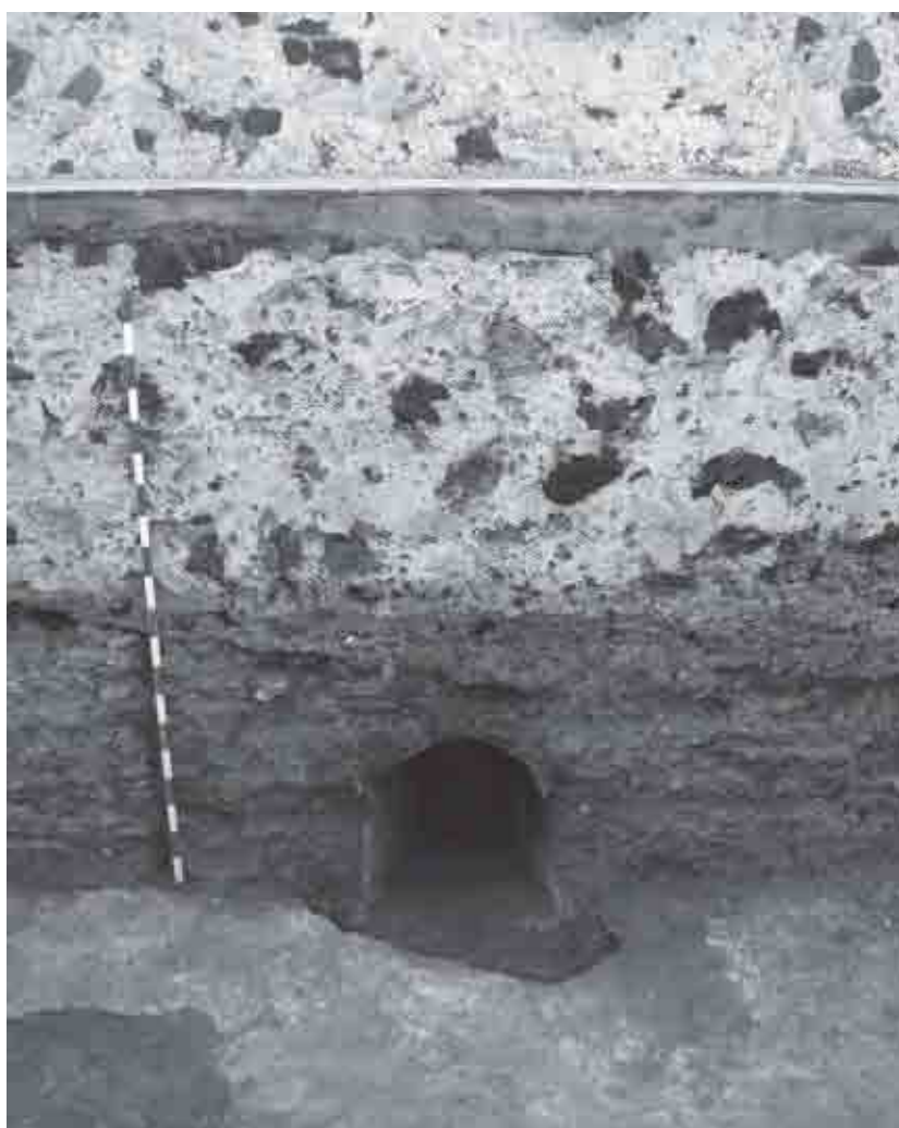
Fig. 12. Aspillera abierta en el extremo norte de la muralla sureste del recinto meridional
