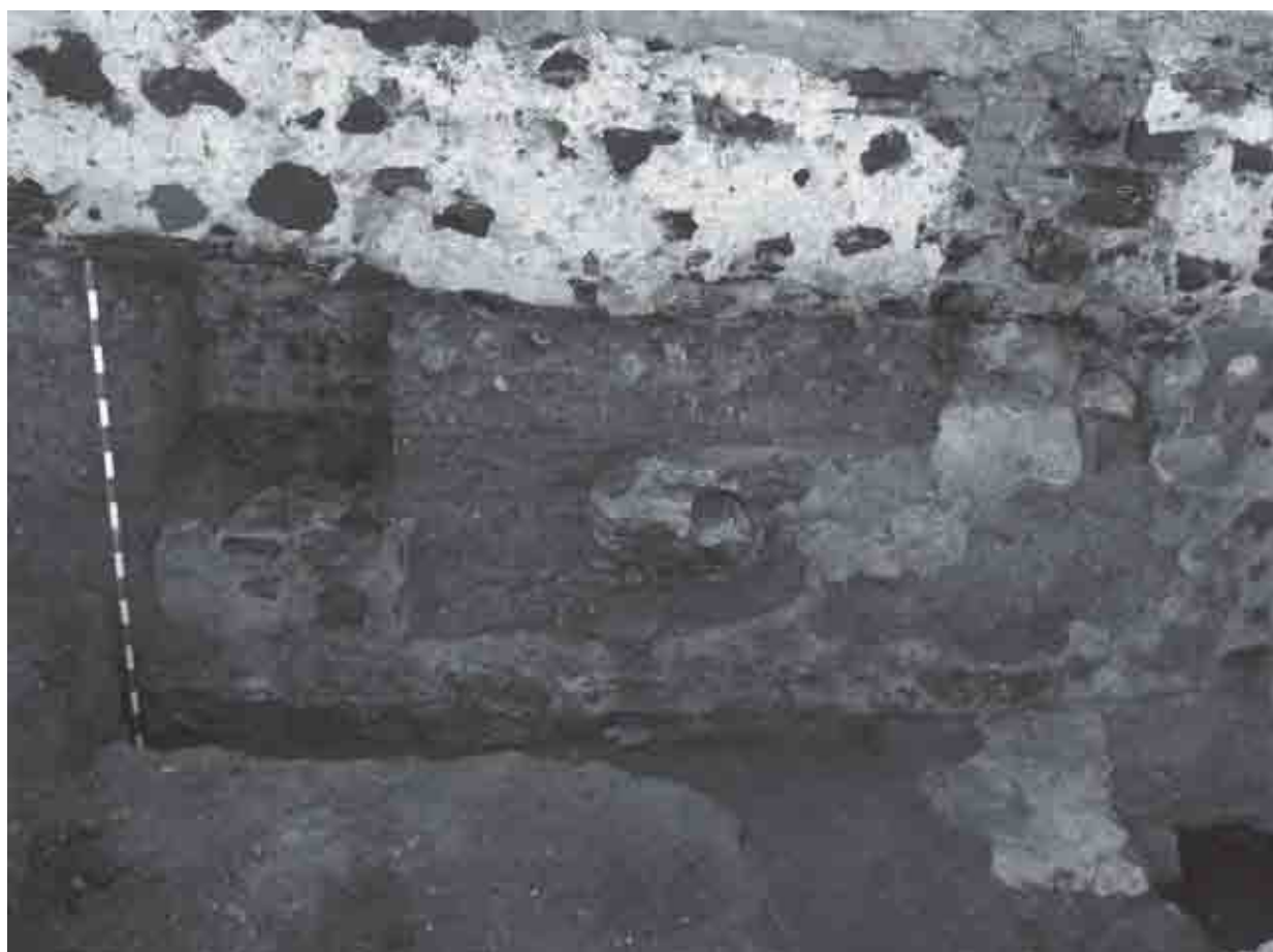
Fig. 13. Aspillera macizada, situada en el extremo sur de la muralla sureste del recinto meridional
