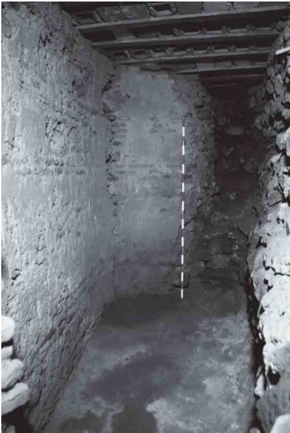
Fig. 22. Torre del Agua. Detalle de los restos del pozo de la noria que aloja esta torre en su interior
