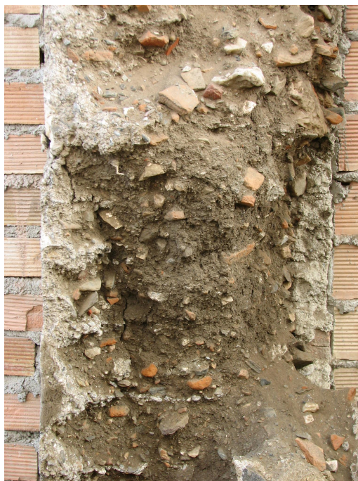
Detalle de la sección correspondiente al alzado de tapial calicostrado.
