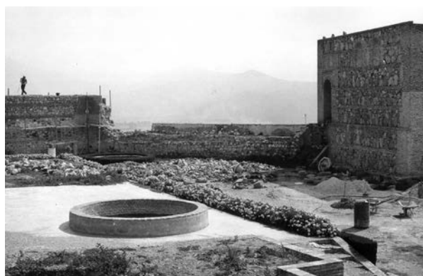
Vista de los aljibes del Patio de Armas
