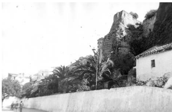
Vista de la Torre del Agua antes de su restauración
